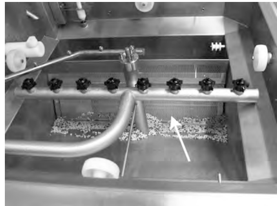
Photo 28 Nettoyage du volet à Granules
