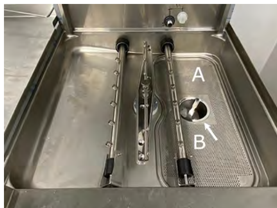
Photo 22 Retirer la grille et le filtre de la cuve
