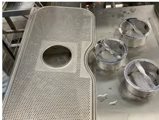
Figure 26 Почистване на филтрите и решетката на резервоара
